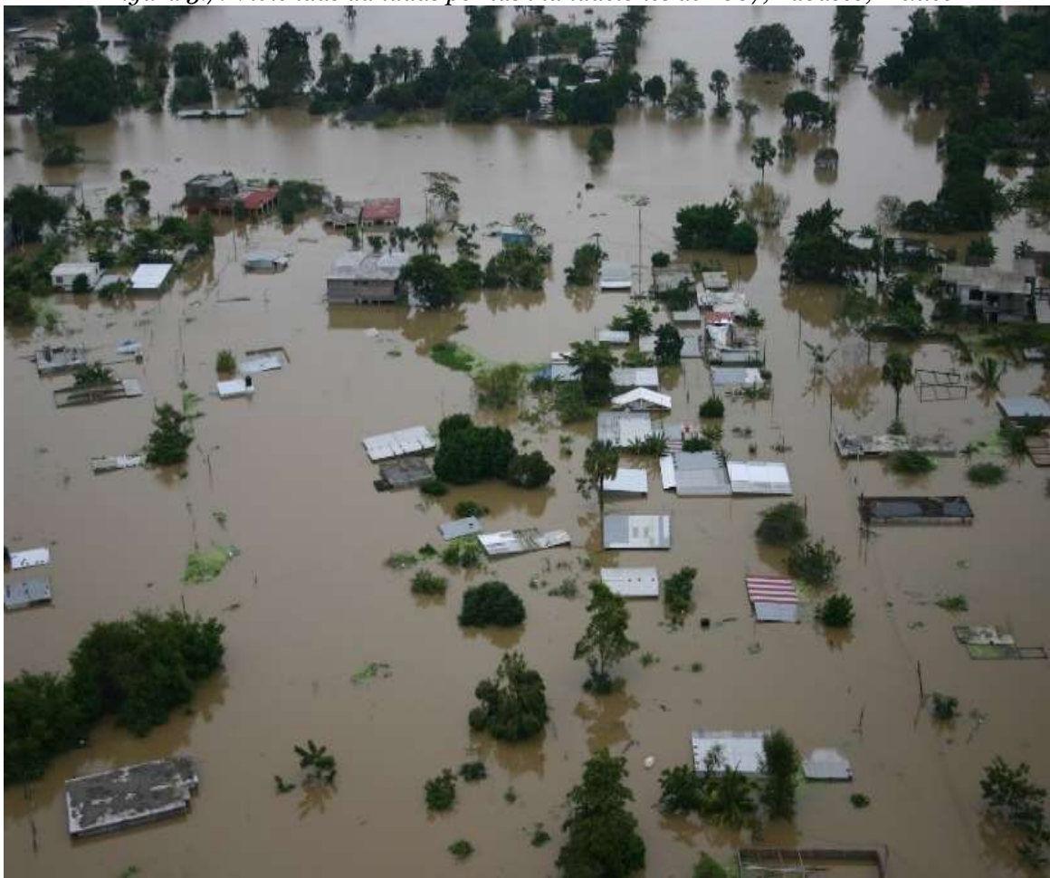
Figura 3.7: Viviendas dañadas por las inundaciones de 2007, Tabasco, México
